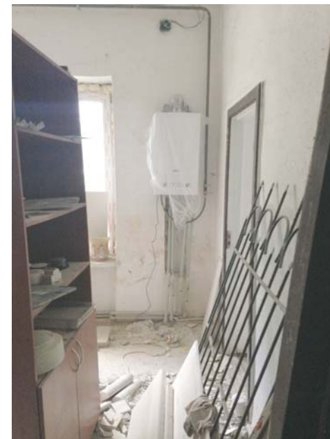
Die neu installierte Gasheizung in der Miniwerkstatt
